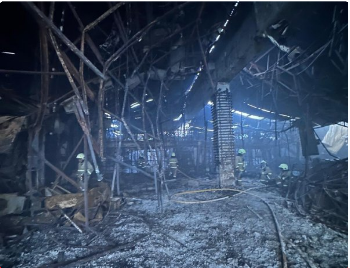
Glodok Plaza yang Hangus Terbakar
